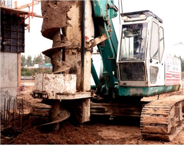
Servicio de pilotes con sistema de hélice continua (CFA), perforados y hormigonados en un solo paso.
