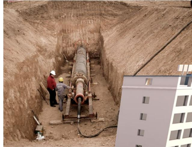
Servicio de túneles por hincado a percusión de tubos de hasta 1.20m de diámetro. No interrumpen el tránsito ni el desarrollo de otras actividades, manteniendo inalterables las superficies de calzada y pavimentos.
